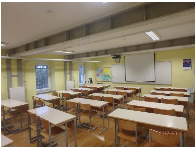
Slika 8: Nadomestni jekleni okvirji v kleti južnega trakta
