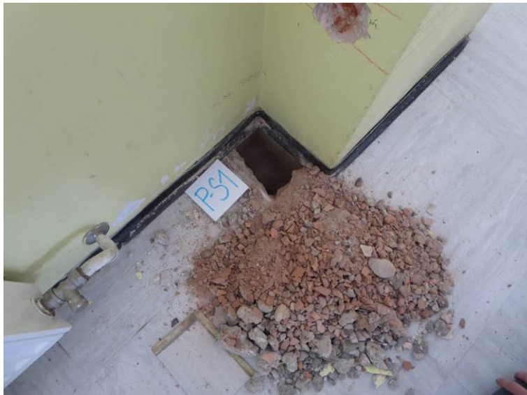
Slika 65: Preiskovalna sonda P-S1 na stropu nad pritličjem (odprto od zgoraj)
