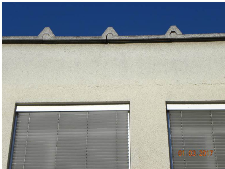
Slika 16: Horizontalna razpoka nad okensko preklado
