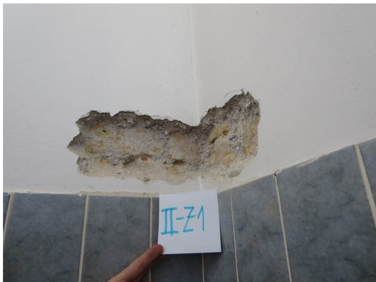
Slika 56: Preiskovalna sonda II-Z1 na zidu v II. nadstropju: opečni zid
