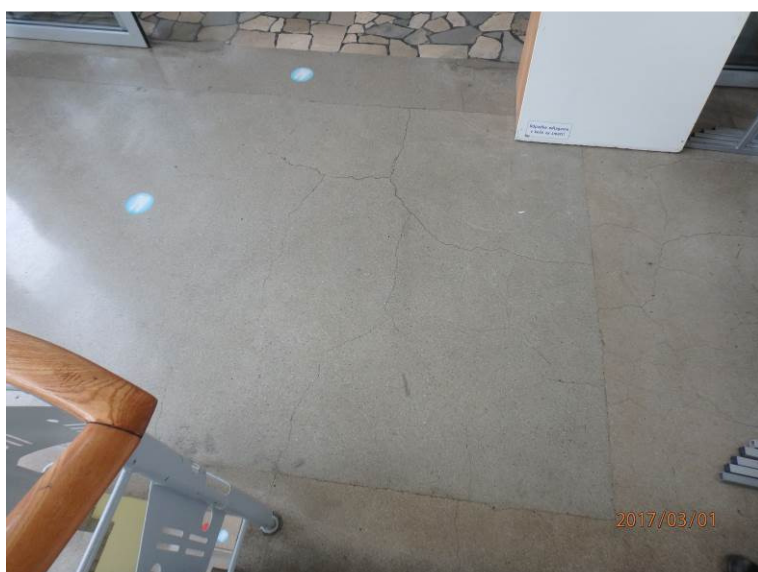
Slika 36: Lokalne razpoke v tlaku
