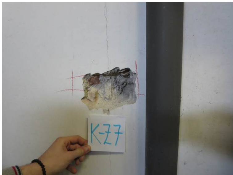
Slika 47: Preiskovalna sonda K-Z7 na zidu v kleti: pozidava vratne odprtine.
