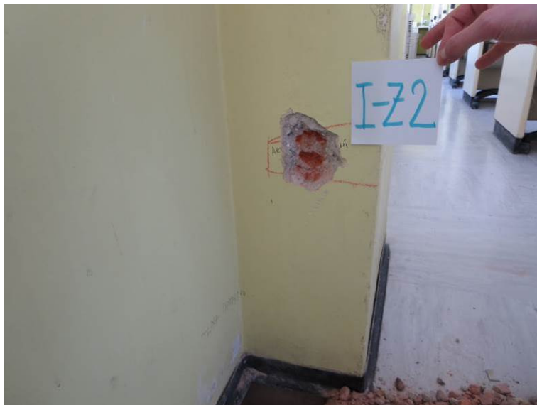
Slika 55: Preiskovalna sonda I-Z2 na okenskemu slopu v I. nadstropju: opečni zid
