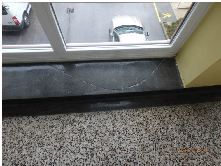
Slika 34: Lokalne razpoke v tlaku
