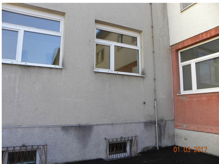
Slika 29: Sledovi zamakanja na fasadi
