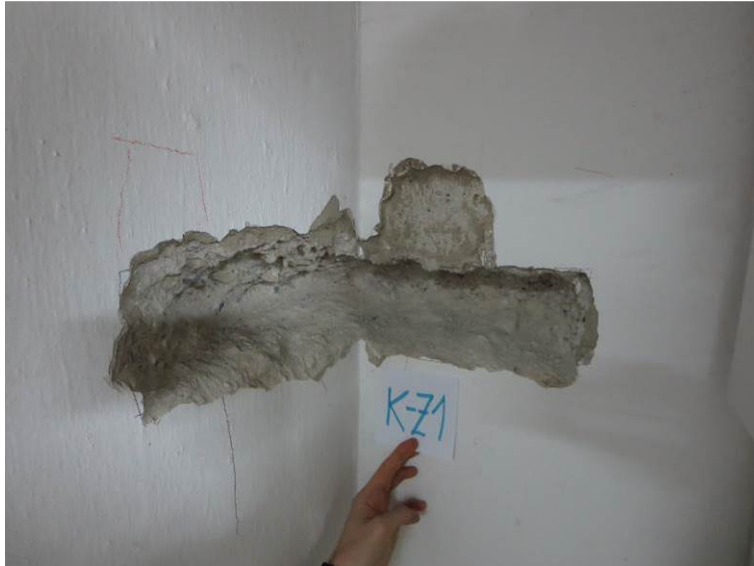
Slika 40: Preiskovalna sonda K-Z1 na zidu v kleti: nearmiran beton
