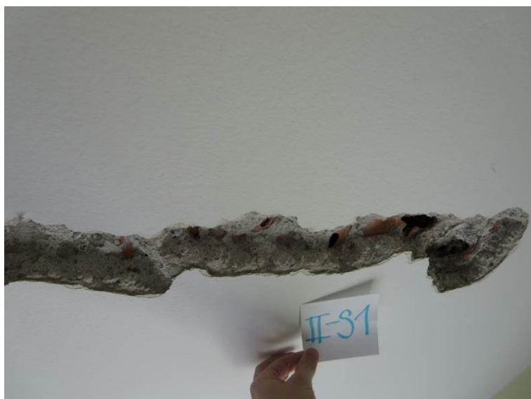
Slika 68: Preiskovalna sonda II-S1 na stropu nad II. nadstropjem (odprto od spodaj): rebričast strop z opečnimi vložki
