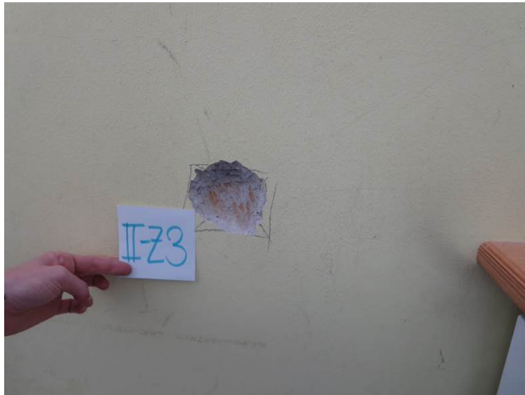
Slika 58: Preiskovalna sonda II-Z3 na zidu v II. nadstropju: opečni zid
