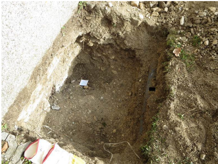
Slika 37: Sondažni izkop ob temelju T1: minimalna razširitev temeljev
