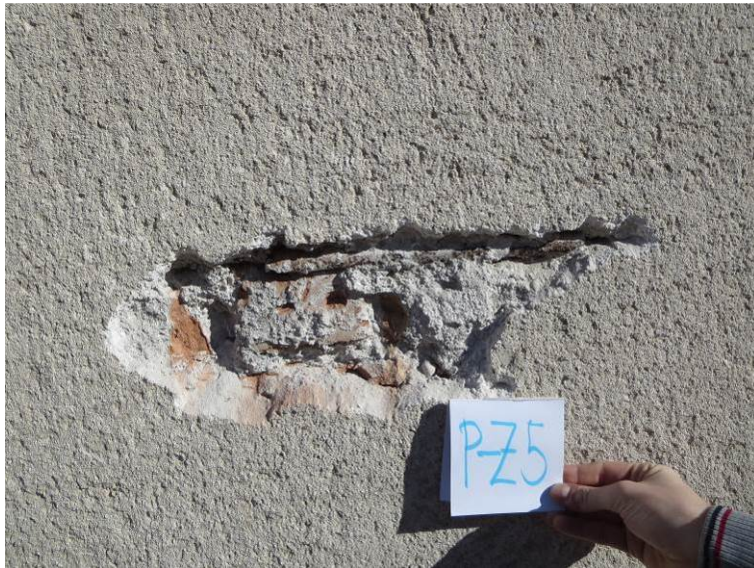
Slika 52: Preiskovalna sonda P-Z5 na zidu v pritličju: opečni zid
