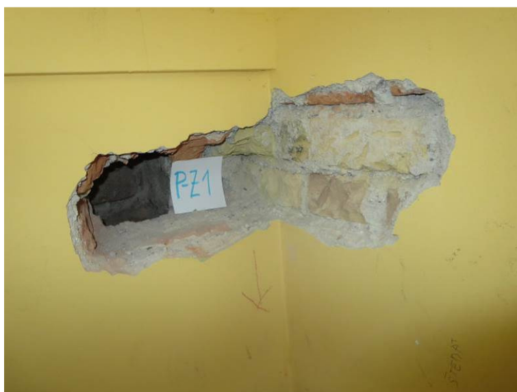
Slika 48: Preiskovalna sonda P-Z1 na zidu v pritličju: opečni zid, vertikalni jašek
