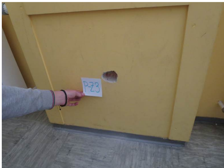
Slika 50: Preiskovalna sonda P-Z3 na zidu v pritličju: opečni zid
