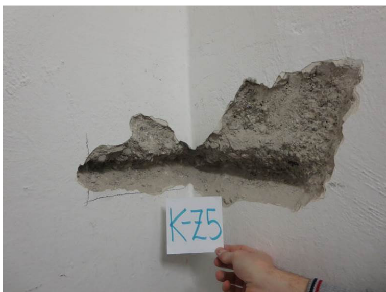
Slika 45: Preiskovalna sonda K-Z5 na zidu v kleti: nearmiran beton
