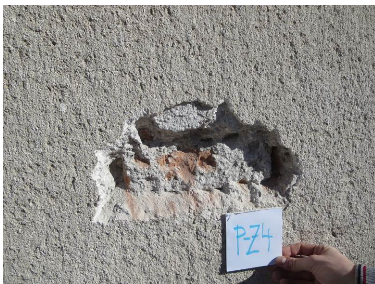
Slika 51: Preiskovalna sonda P-Z4 na zidu v pritličju: opečni zid
