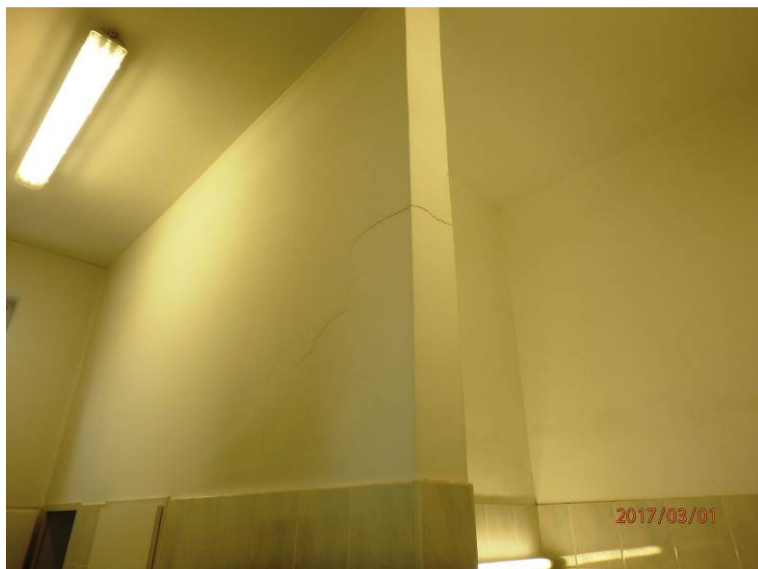
Slika 31: Več poševnih, horizontalnih in vertikalnih razpok na predelnih stenah sanitarij v I. in II. nadstropju južnega trakta
