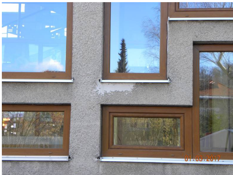
Slika 19: Lokalne poškodbe fasadnega ometa, delno sanirane
