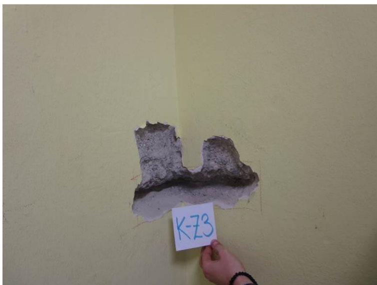
Slika 42: Preiskovalna sonda K-Z3 na zidu v kleti: nearmiran beton
