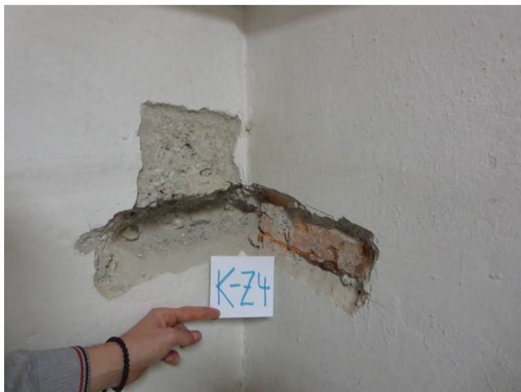
Slika 43: Preiskovalna sonda K-Z4 na zidu v kleti, zunanja stena: nearmiran beton, notranja stena vzdolž hodnika: opečni zid
