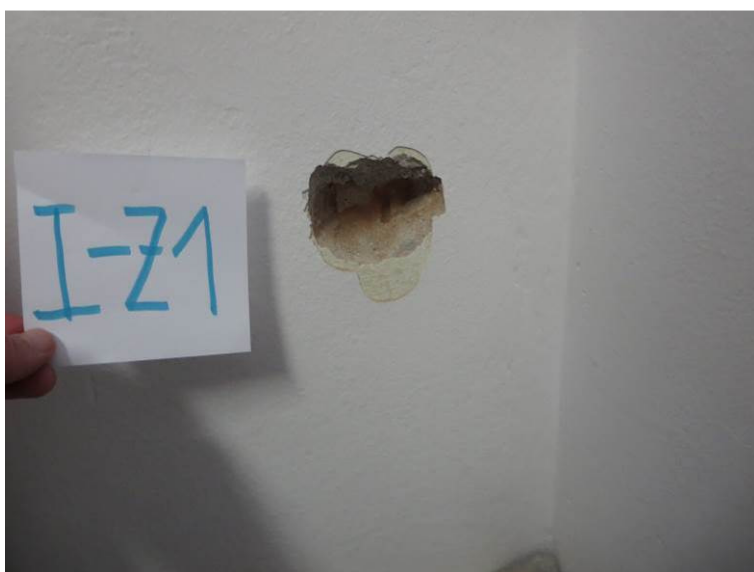
Slika 54: Preiskovalna sonda I-Z1 na okenskemu slopu v I. nadstropju: opečni zid
