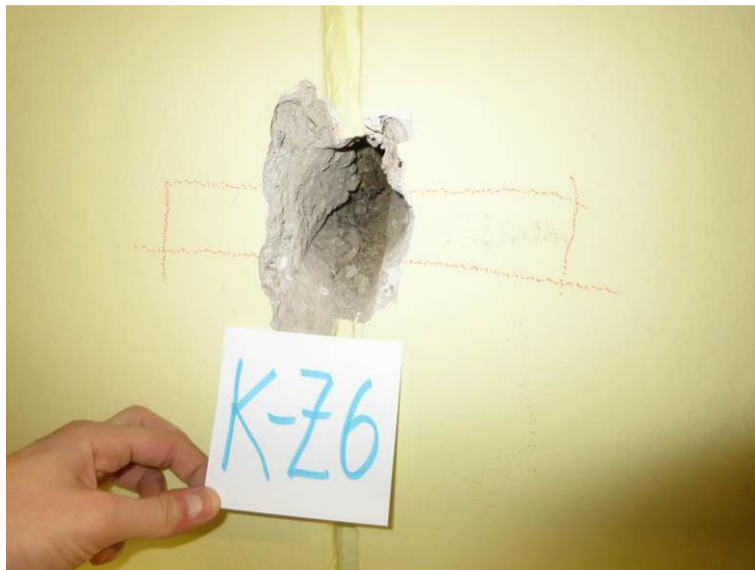
Slika 46: Preiskovalna sonda K-Z6 na zidu v kleti – mesto dilatacije. Dilatacija je zapolnjena z drobirjem.
