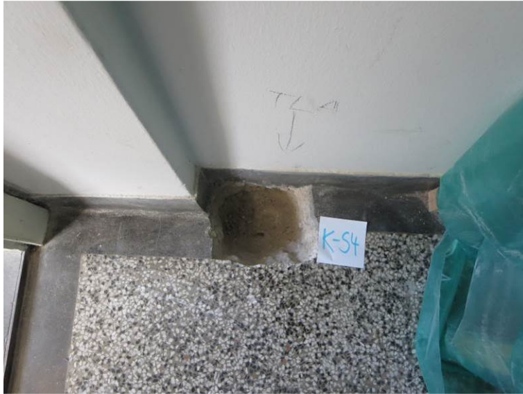
Slika 64: Preiskovalna sonda K-S4 na stropu nad kletjo (odprto od zgoraj)
