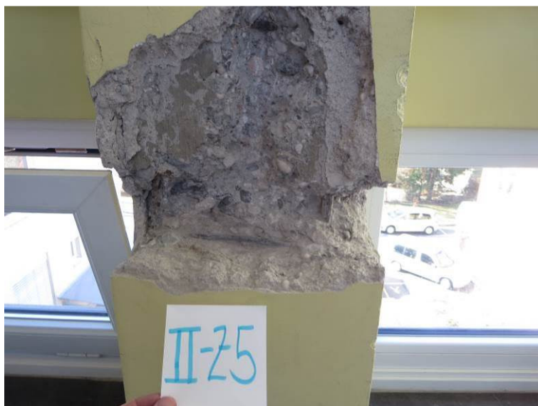
Slika 60: Preiskovalna sonda II-Z5 na stebru v II. nadstropju: AB steber
