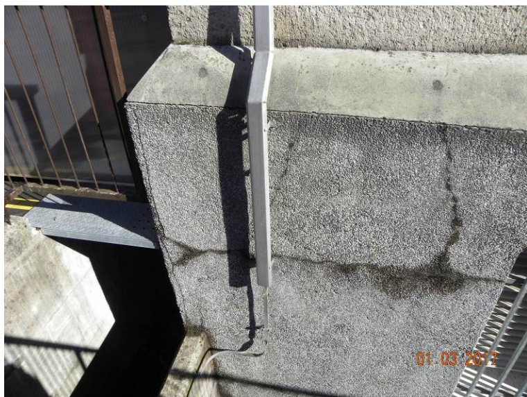
Slika 10: Lokalne poškodbe cokla v območju ojačitev
