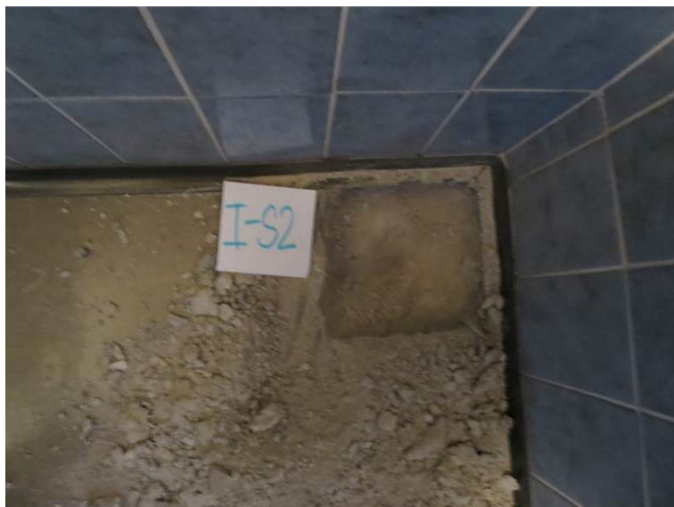
Slika 67: Preiskovalna sonda I-S2 na stropu nad I. nadstropjem (odprto od zgoraj)
