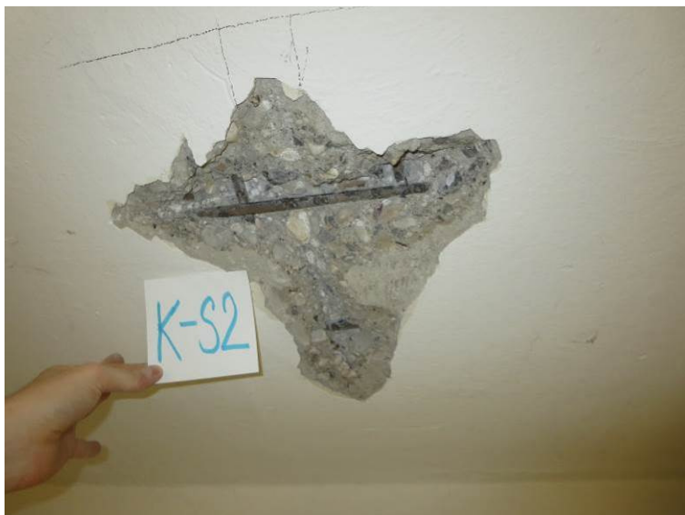
Slika 62: Preiskovalna sonda K-S2 na stropu nad kletjo (odprto od spodaj): AB plošča
