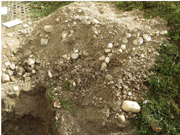
Slika 38: Sondažni izkop ob temelju T1: material izkopa
