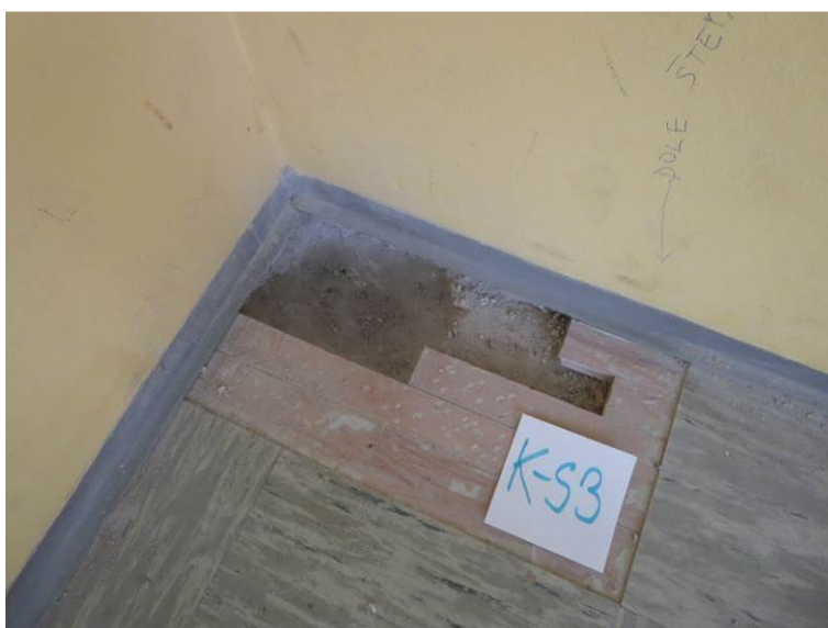
Slika 63: Preiskovalna sonda K-S3 na stropu nad kletjo (odprto od zgoraj)
