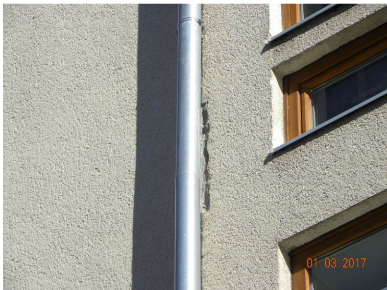
Slika 25: Poškodbe fasade v območju dilatacije, sanirane
