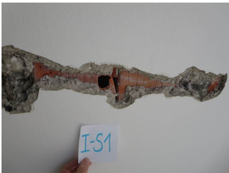
Slika 66: Preiskovalna sonda I-S1 na stropu nad I. nadstropjem (odprto od spodaj): rebričast strop z opečnimi vložki
