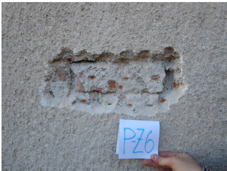
Slika 53: Preiskovalna sonda P-Z6 na zidu v pritličju: opečni zid
