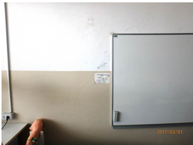
Slika 32: Poševna razpoka na prečni steni v II. nadstropju južnega trakta
