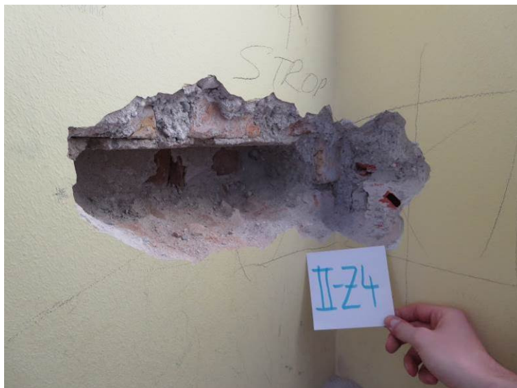
Slika 59: Preiskovalna sonda II-Z4 na zidu v II. nadstropju: opečni zid, odvzem vzorca opeke
