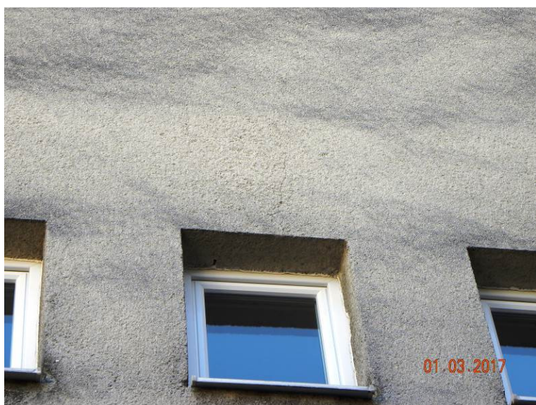
Slika 15: Vertikalna razpoka nad okensko preklado
