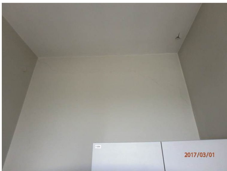
Slika 33: Razpoka na steni pod stropom v II. nadstropju severnega trakta
