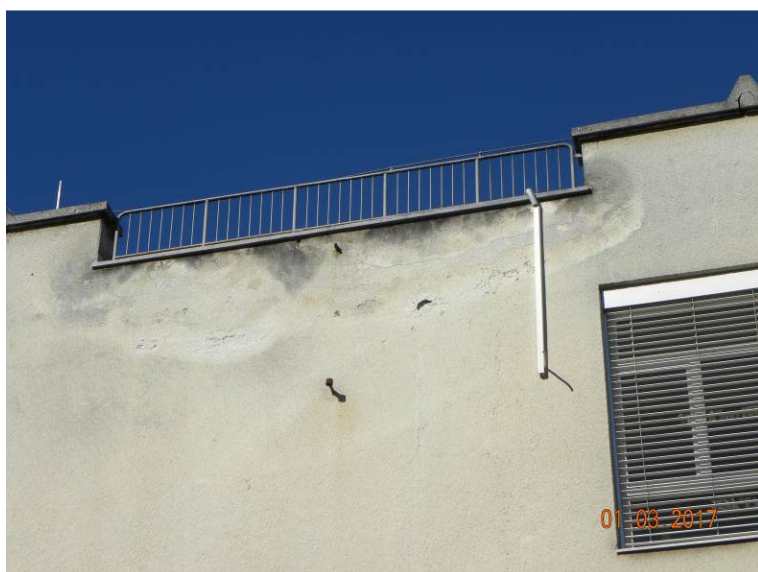
Slika 30: Sledovi zamakanja na fasadi
