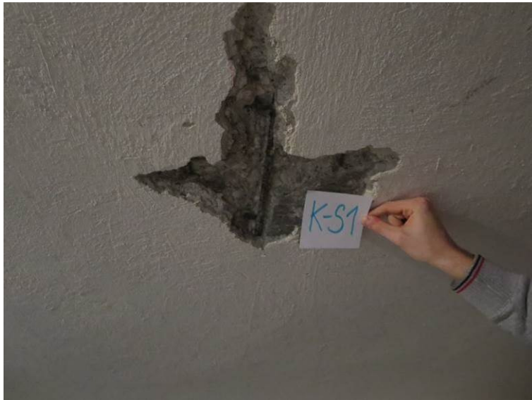
Slika 61: Preiskovalna sonda K-S1 na stropu nad kletjo (odprto od spodaj): AB plošča
