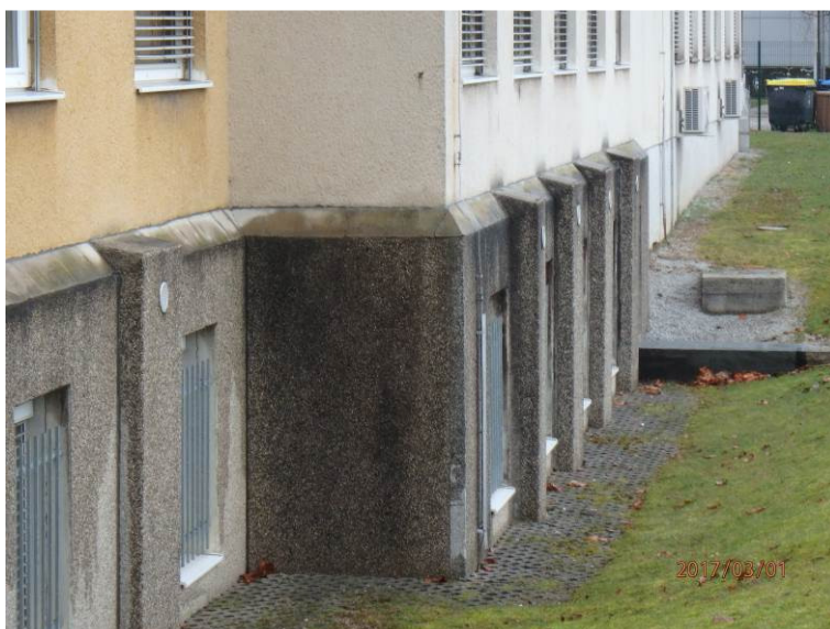
Slika 9: Ojačitve kletnih zidov in temeljev v območju severnega trakta
