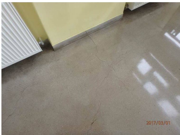
Slika 35: Lokalne razpoke v tlaku
