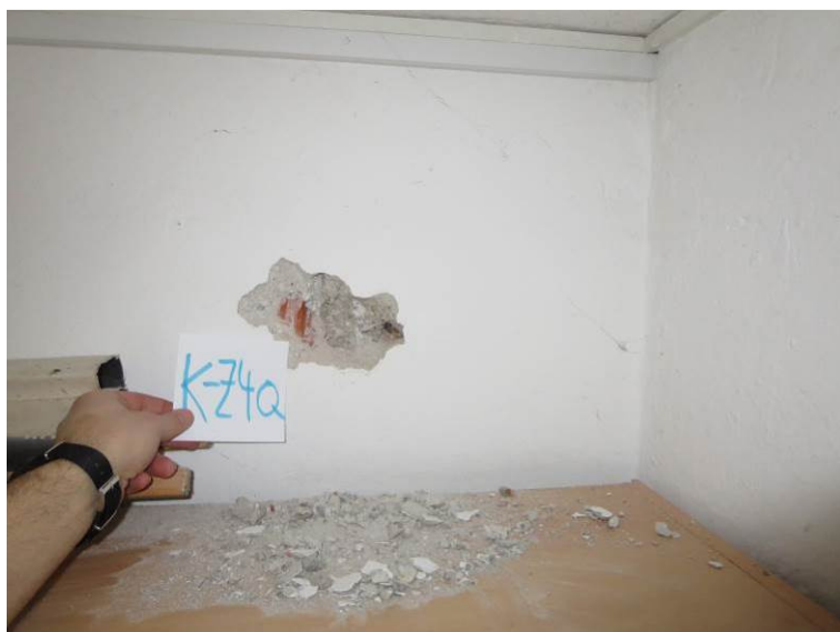
Slika 44: Preiskovalna sonda K-Z4a na zidu v kleti, notranja stena vzdolž hodnika: delno opečni zid, delno betonska stena
